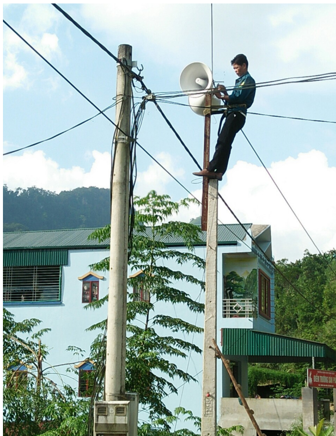
Lắp đặt loa truyền thanh tại xã Nậm Chảy
